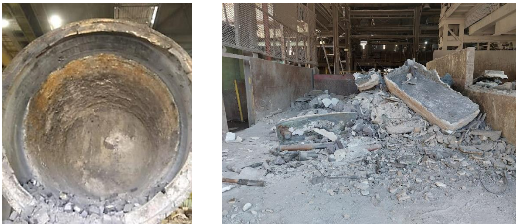
Figura 2 – Desmonte de panela de aço (esq.) e distribuir de aço (dir.).
